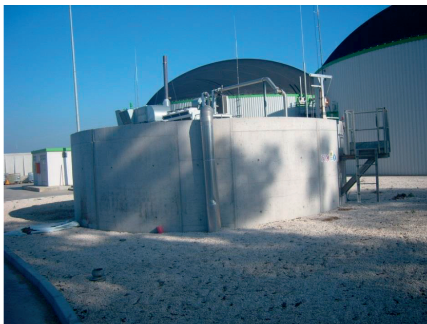
Figura 5 - La vasca di stoccaggio dei liquami
