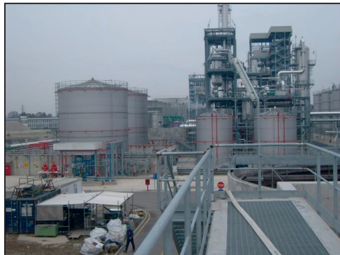
Figura 15 - Serbatoi di stoccaggio del bioetanolo
