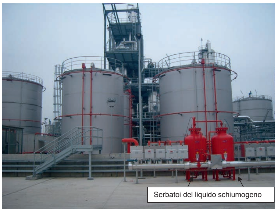
Figura 19 - Serbatoi della miscela schiumogena
