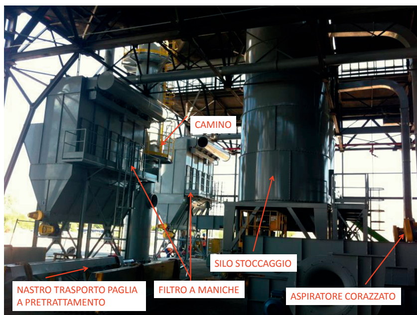
Figura 6 - Sezione dell'impianto di alimentazione della paglia dove sono visibili i filtri a maniche, l'aspiratore corazzato ed il camino
