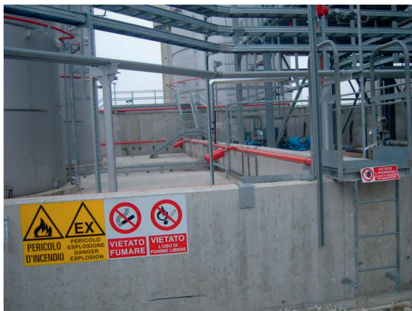
Figura 18 - Sistema di immissione di liquido schiumogeno nel bacino contenente i serbatoi di stoccaggio di bioetanolo
