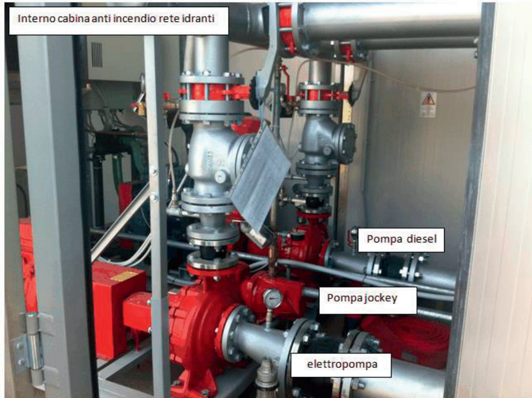
Figura 20 - Pompe della stazione di pompaggio
