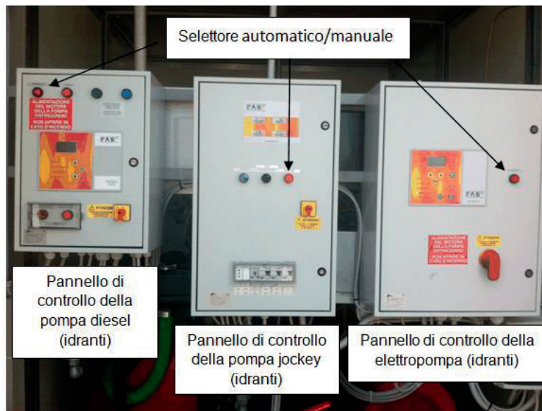
Figura 23 - Pannelli di controllo delle pompe
