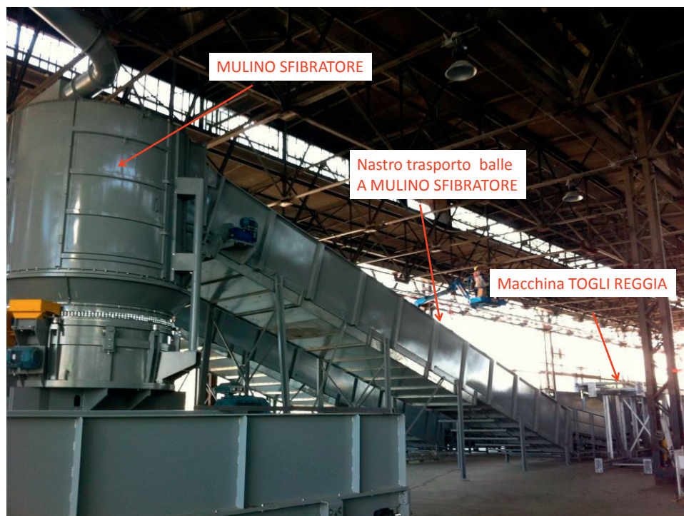
Figura 7 - Sezione dell'impianto di alimentazione della paglia dove è visibile il mulino sfibratore
