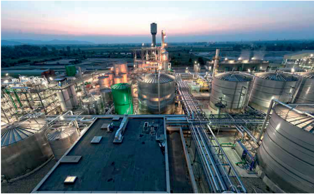
Figura 1 - Impianto di Crescentino
